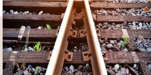
SNCF Réseau - Rail infrastructure maintenance performance
