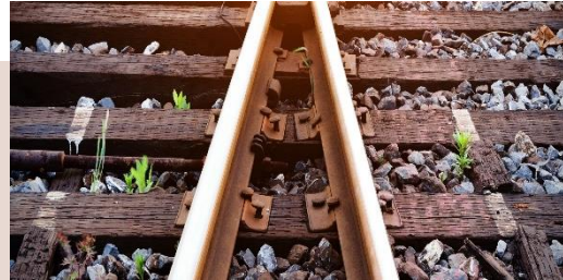
SNCF Réseau - Rail infrastructure maintenance performance
